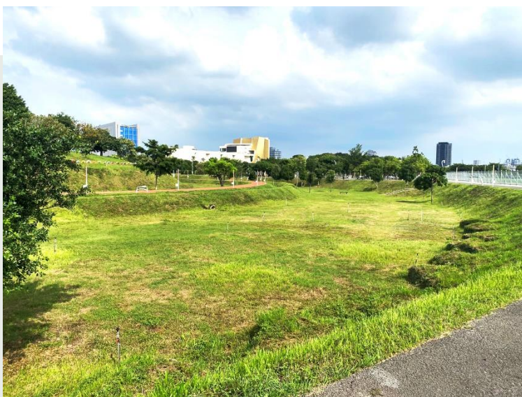
中央公園乾式滯洪池一景
