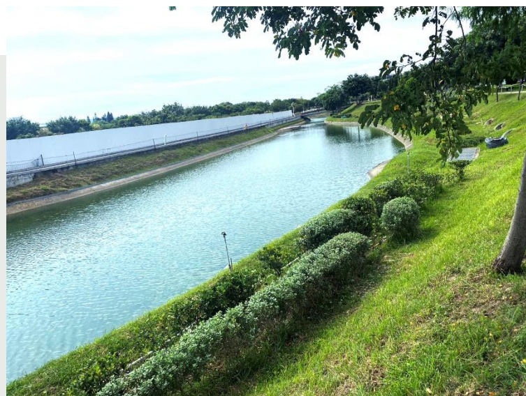
中央公園濕式滯洪池一景
